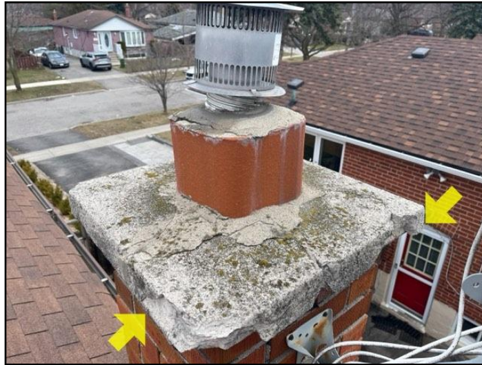
Spalling
